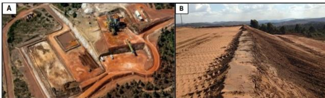
Figura 9. A) Planta de desagüe piloto construída na Mina do Pico. (B) Aterro experimental formado com os rejeitos arenosos filtrados e espessados. (Relatório de projeto Vale S.A., apud Boccamino, 2017).
